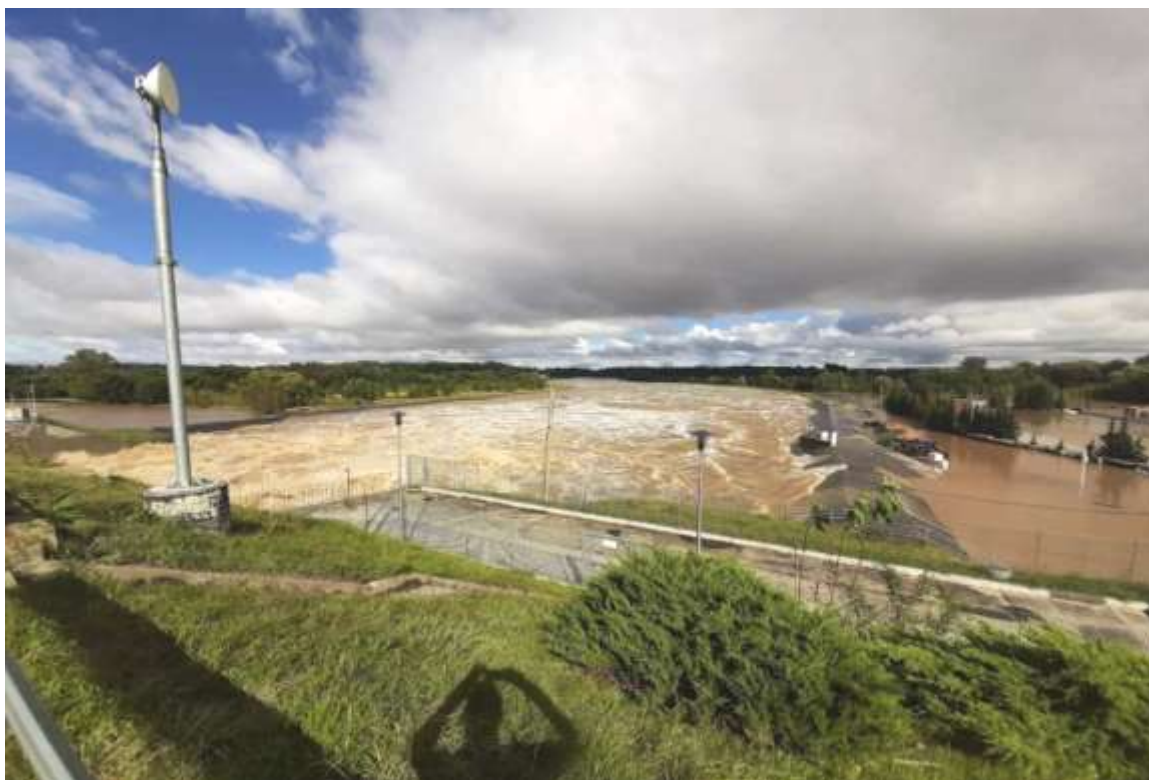
Rysunek 18.3 Widok na dolne stanowisko (2024-09-15) przy zrzucie Q = 800 \text{ m}^3/\text{s} – niesymetryczny zrzut wody przez segmenty budowli zrzutowej już przy tym odpływie powoduje falowanie sięgające góry ubezpieczeń
